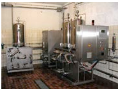
3-stufige Wasserfiltration Filterkerzenanlage mit integrierter CIP-Einheit
