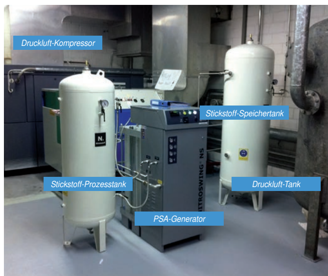
Stickstoff-Eigenproduktion – PSA Verfahren bei Kaffee-Rösterei in der Schweiz
