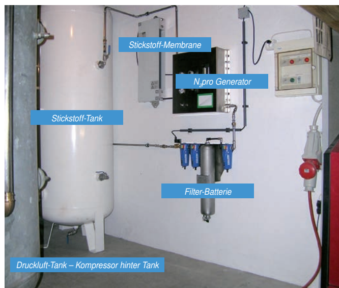
Stickstoff-Produktion aus Druckluft bei Cave Jean-René Germanier SA, Vétroz
